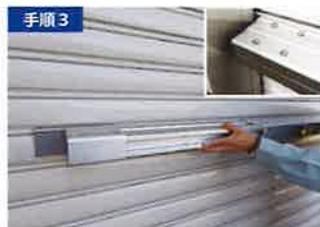
ノブボルトを締め、本体部分を伸ばして、もう片方の隙間に差し込みます。
