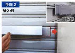
片方の隙間(スラットとガイドレールの間)にアンカーを差し込みます。
