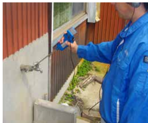
水漏れ箇所を調査し、適切に対処します。
